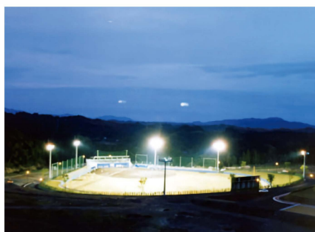
緒方町総合運動公園 ナイター照明設備工事
