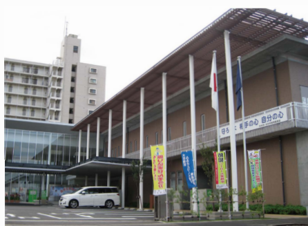
大分市大在市民センター 新築電気設備工事
