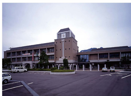
由布市庄内庁舎 新築電気設備工事
