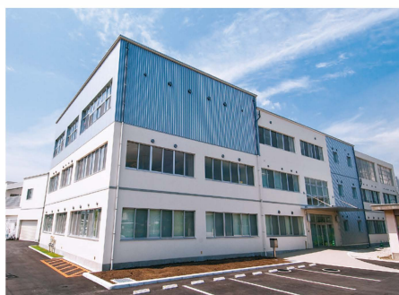
大分県子ども家庭センター事務棟 新築電気設備工事 🏆【大分県土木建築部長表彰】
