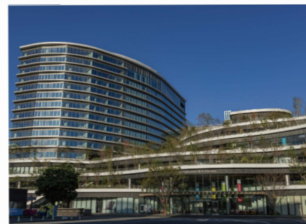
熊本桜町地区第一種市街地再開発工事 空調・自動制御設備工事
