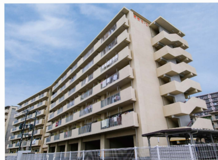
大分県城南住宅S-2棟 新築電気設備工事
